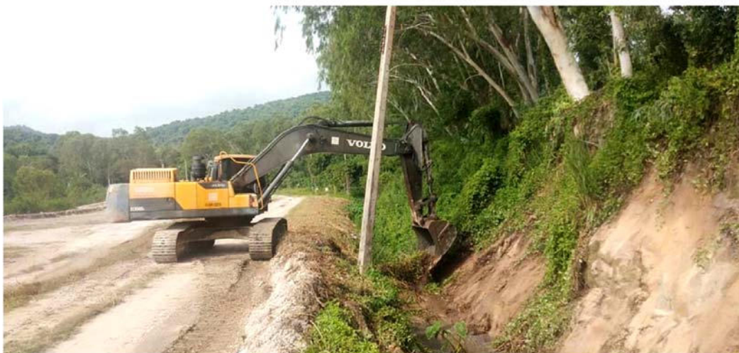
รูปที่ 4 การขุดลอกร่องน้ำ
