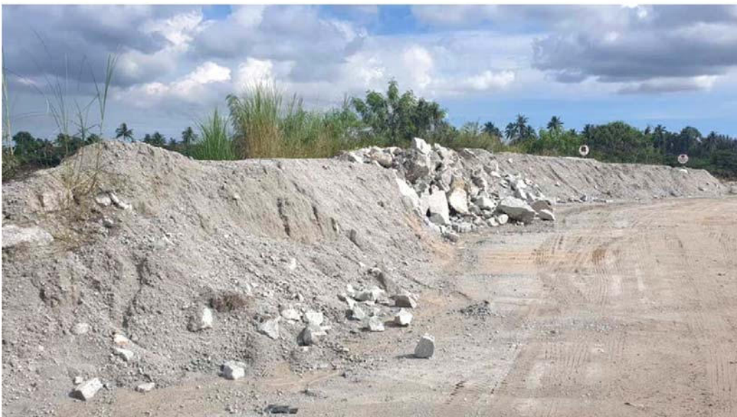
รูปที่ 2 คั่นทำนบดินบริเวณขอบบ่อเหมืองของโครงการ
